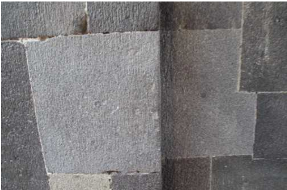
Hasil pemahatan batu dalam rangka penyelarasan antara batu baru dengan batu lama (Foto koleksi Wahyu Indrasana)
