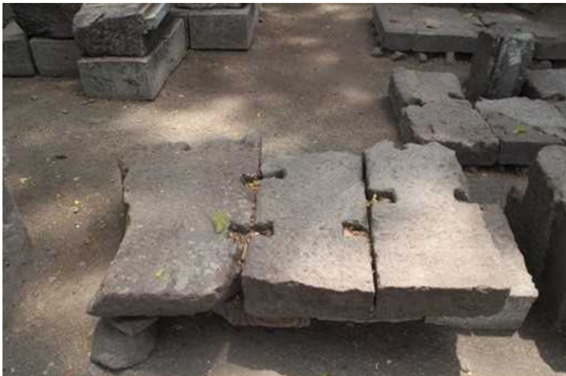
Lubang-lubang untuk pasak ekor burung pada batu-batu Candi Morangan (Foto koleksi Wahyu Indrasana)
