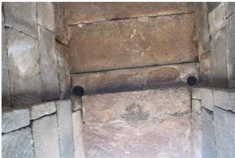
Lubang purus untuk daun pintu pada ambang pintu gapura Candi Barong (Foto koleksi Wahyu Indrasana)
