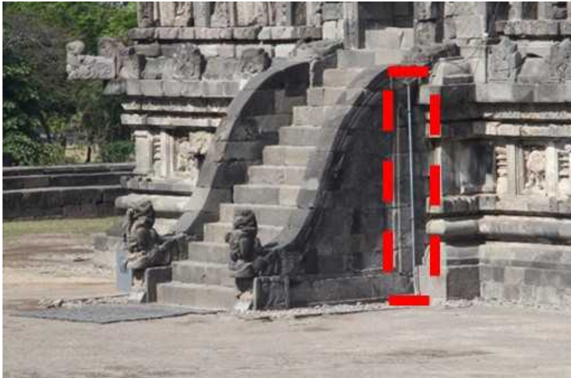
Konduktor penangkal petir yang menghubungkan splitzen dengan grounding di bawah tanah. (Foto koleksi Wahyu Indrasana)
