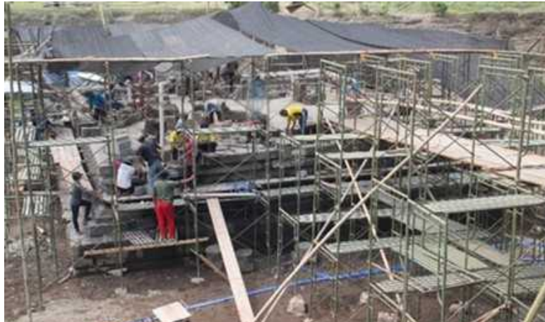
Penggunaan scaffolding dalam pemugaran Candi Kedulan (Foto koleksi Wahyu Indrasana)
