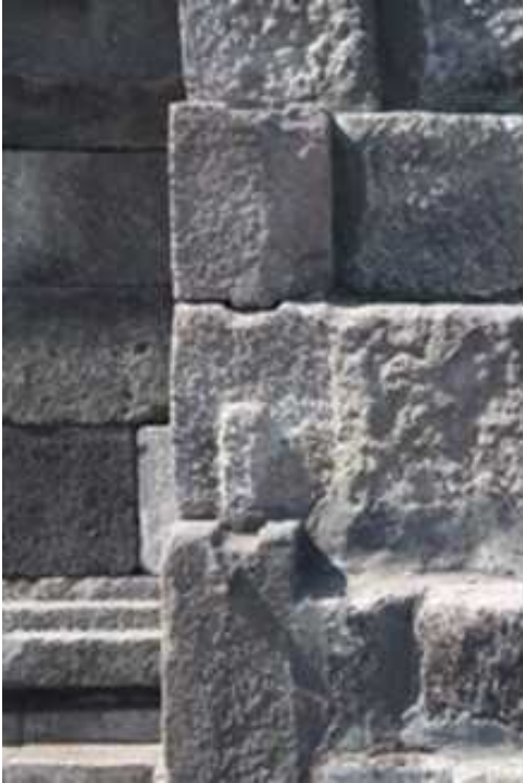
Susunan batu dengan pengait dan purus pada Pagar Halaman I sudut barat daya Komplek Candi Prambanan (Foto koleksi Wahyu Indrasana)
