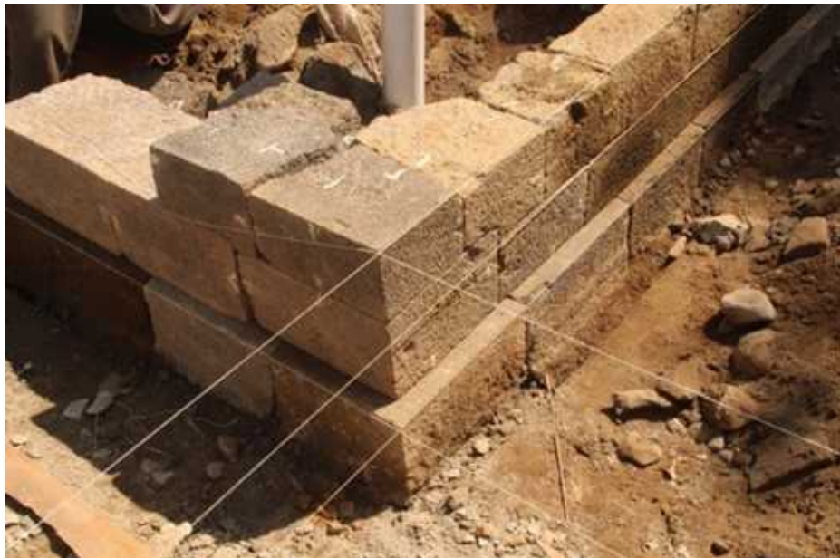
Susunan batu tanpa pengait pada Candi Palgading (Foto koleksi Wahyu Indrasana)
