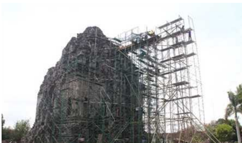
Pemasangan perancah dari pipa logam dan scaffolding untuk pemugaran Candi Kalasan (Foto koleksi Wahyu Indrasana)
