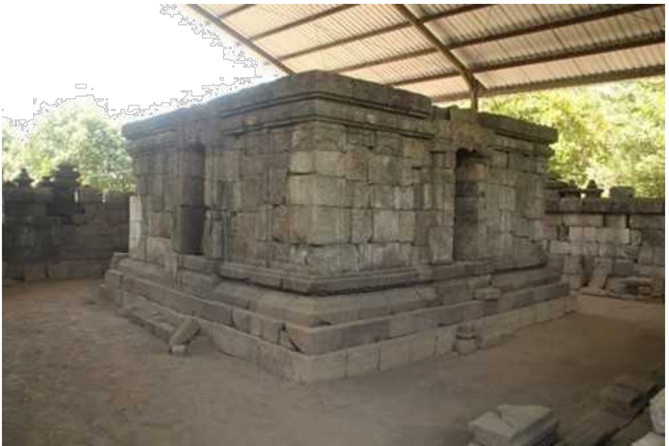
Susunan percobaan tubuh Candi Kedulan yang terdiri dari satu lapis batu (Foto koleksi Wahyu Indrasana)
