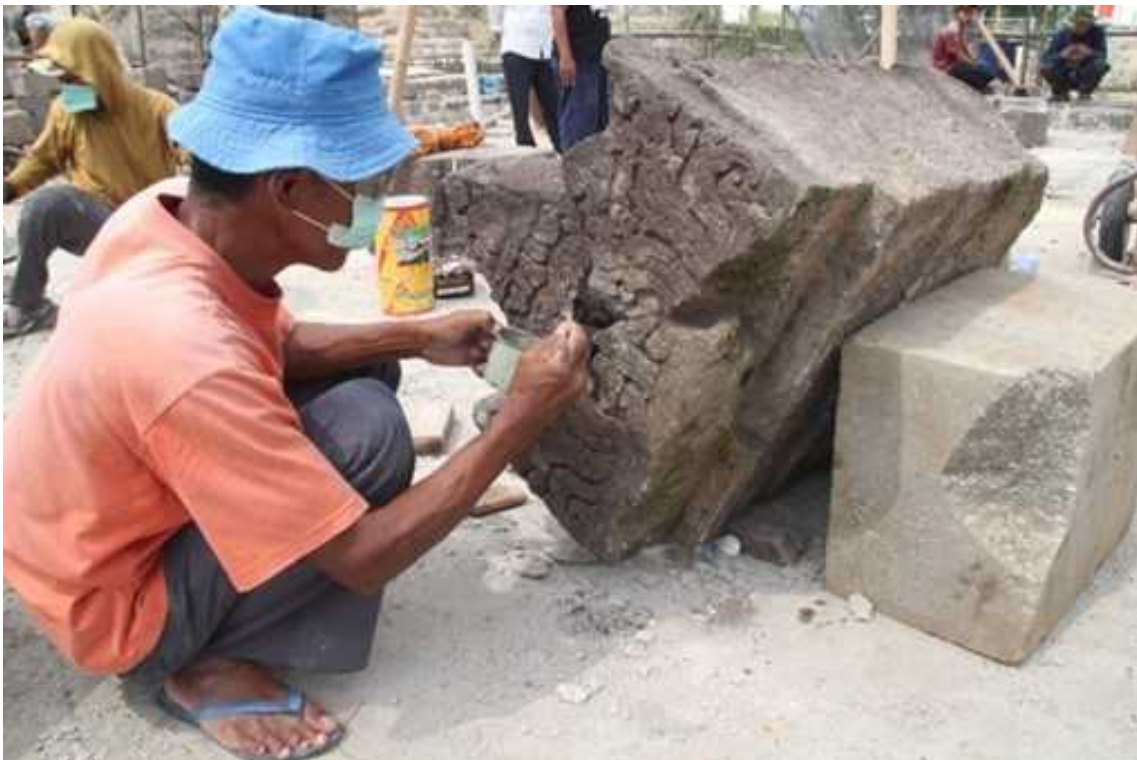
Penggunaan epoksi resin untuk penyambungan batu (Foto koleksi Wahyu Indrasana)
