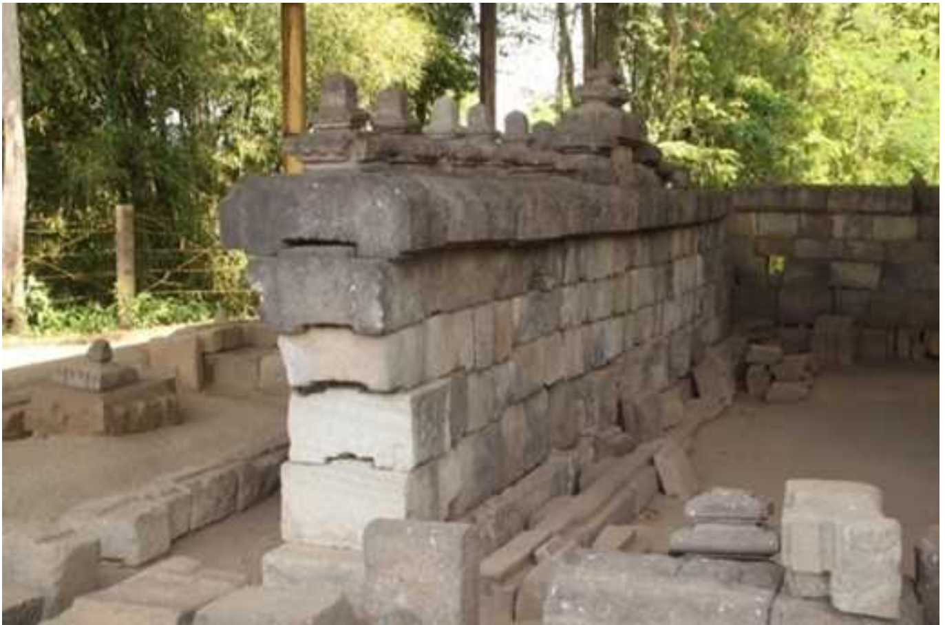
Susunan batu dengan pengait pada pagar langkan Candi Kedulan (Foto koleksi Wahyu Indrasana)
