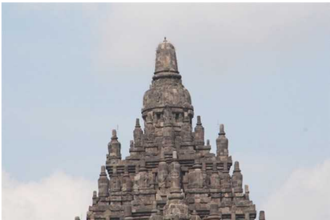
Penangkal petir Candi Siwa Prambanan berbentuk mangkuk dengan splitzen berujung pendek (Foto koleksi Wahyu Indrasana)
