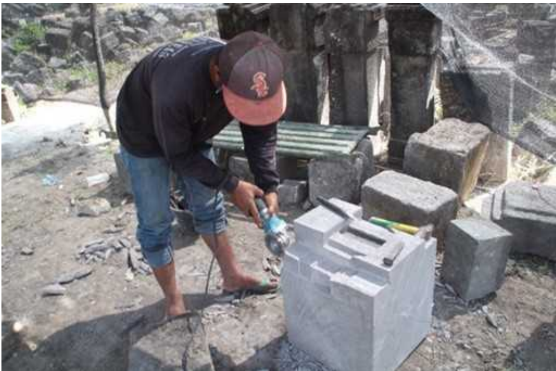
Penggergajian batu dalam rangka pembuatan batu pengganti (Foto koleksi Wahyu Indrasana)
