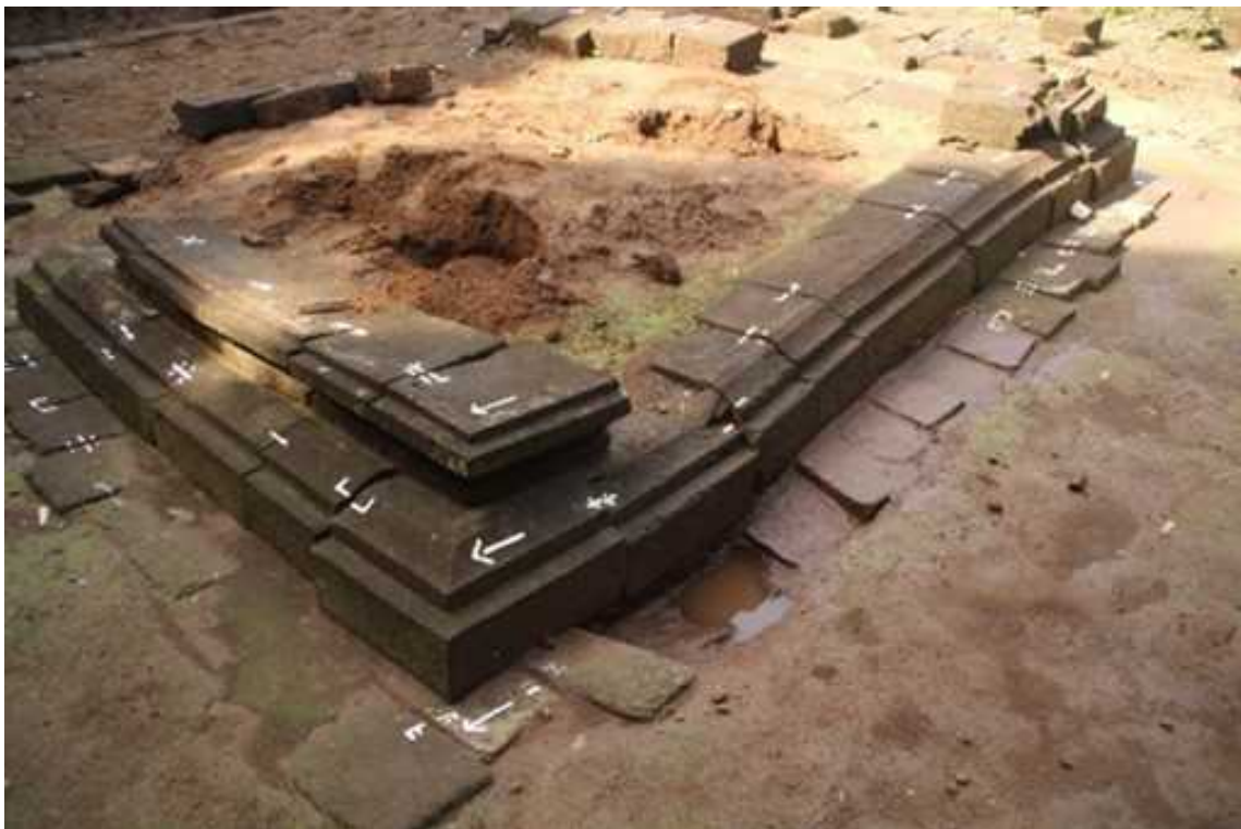
Pemberian tanda pada batu sebelum pembongkaran batu-batu Candi Palgading (Foto koleksi Wahyu Indrasana)
