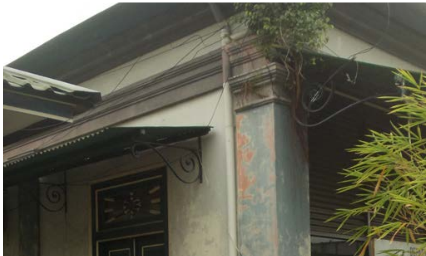
Bentuk konsol pada bangunan Indis Bintaran
