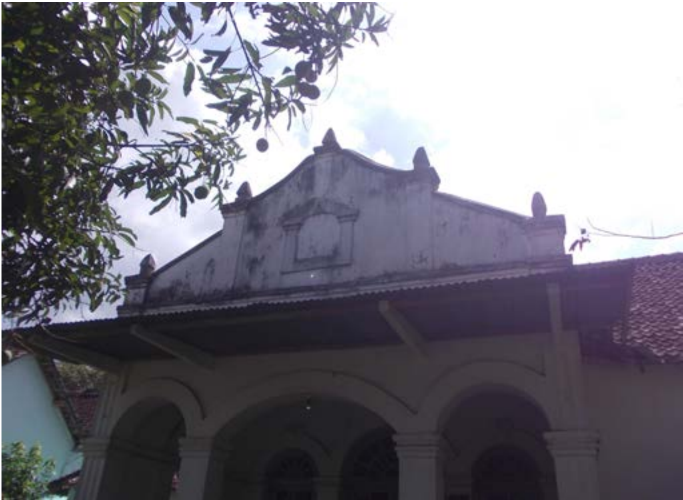
Curvilinear gable pada Eks Rumah Dinas Pabrik Gula Sewugalur milik Bapak Suyitno
