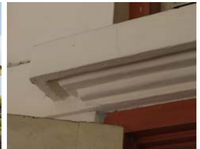
Terdapat ornamen pada bagian dinding di antara jendela dan ventilasi berupa tonjolan dengan ukiran geometri Rumah Jalan Dewa Nyoman Oka no. 11
