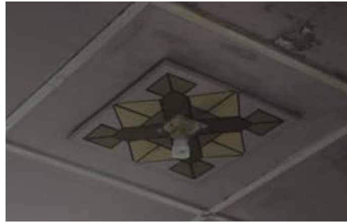
2 ornamen hias plafond berupa gambar geometrik persegi dan bentuk 'x'. Rumah tinggal di Jalan Sajiono no. 9 Kotabaru
