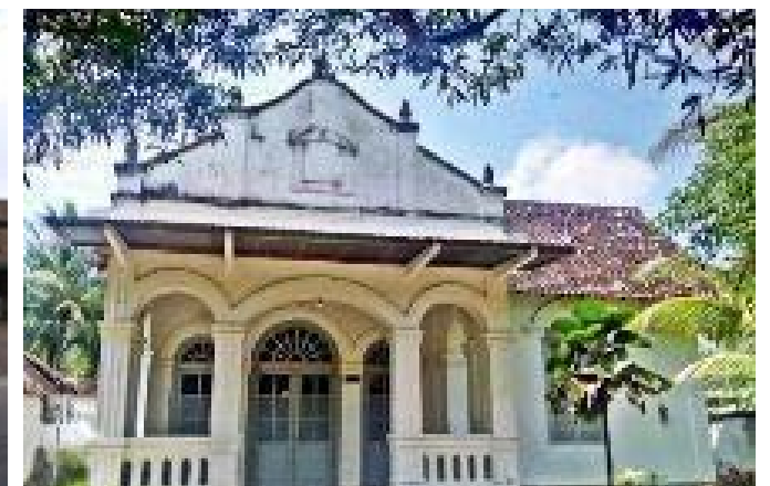
acroterion puncak dan acroterion sudut pada bangunan eks rumah dinas PG Sewugalur Sumber Foto: Lengkong S.G., 2017
