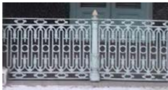
Balustrade pada Rumah indis di Bintaran
