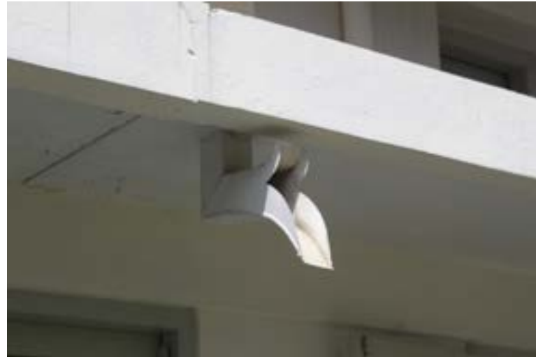
Ornamen pada talang air hujan berupa bentuk lengkungan yang terbelah dua ke atas dan ke bawah pada Bangunan RS. Bethesda
