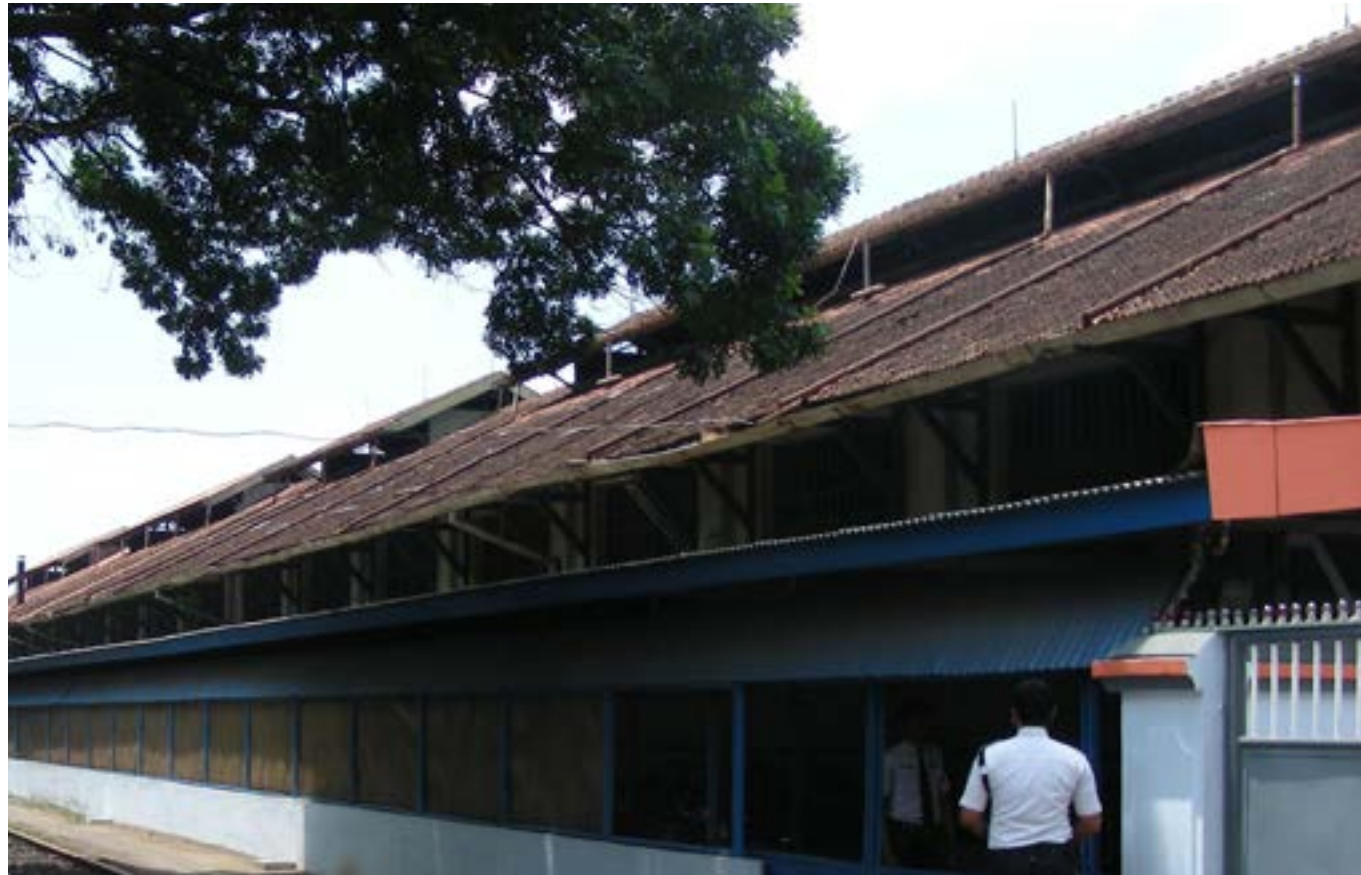
Roof monitor pada Balai Yasa
