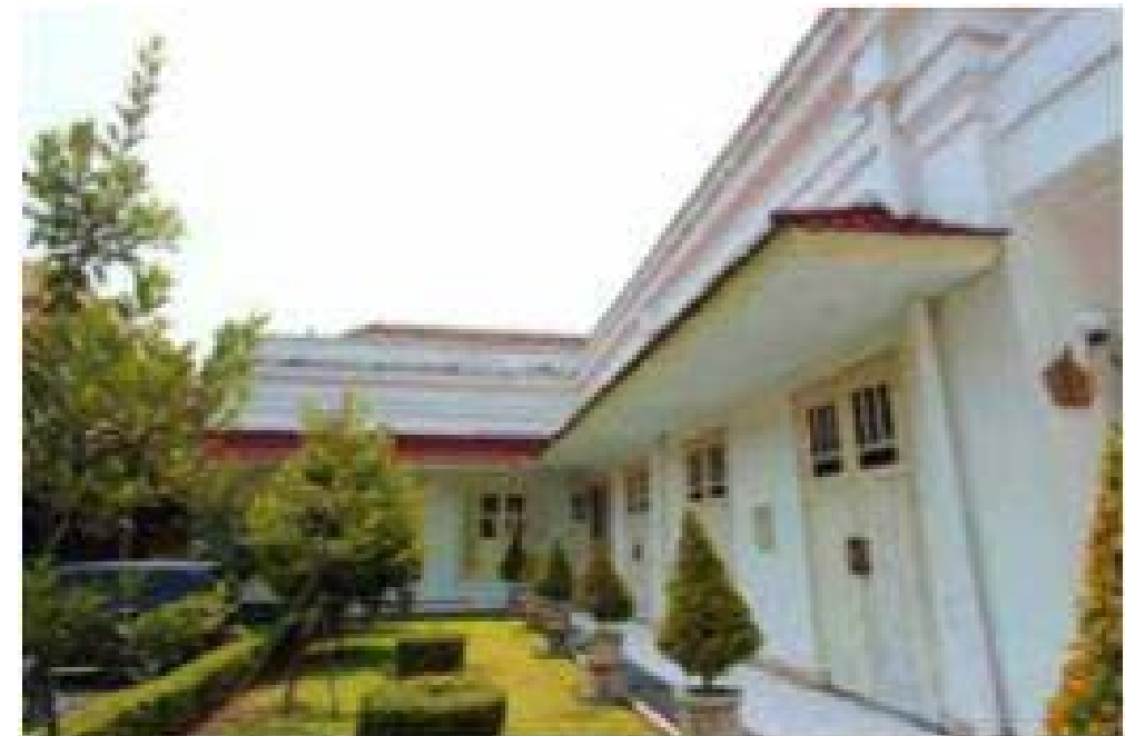
Contoh overstek pada bangunan sisi utara gedung DPRD DIY Sumber: Dinas Kebudayaan DIY, 2016
