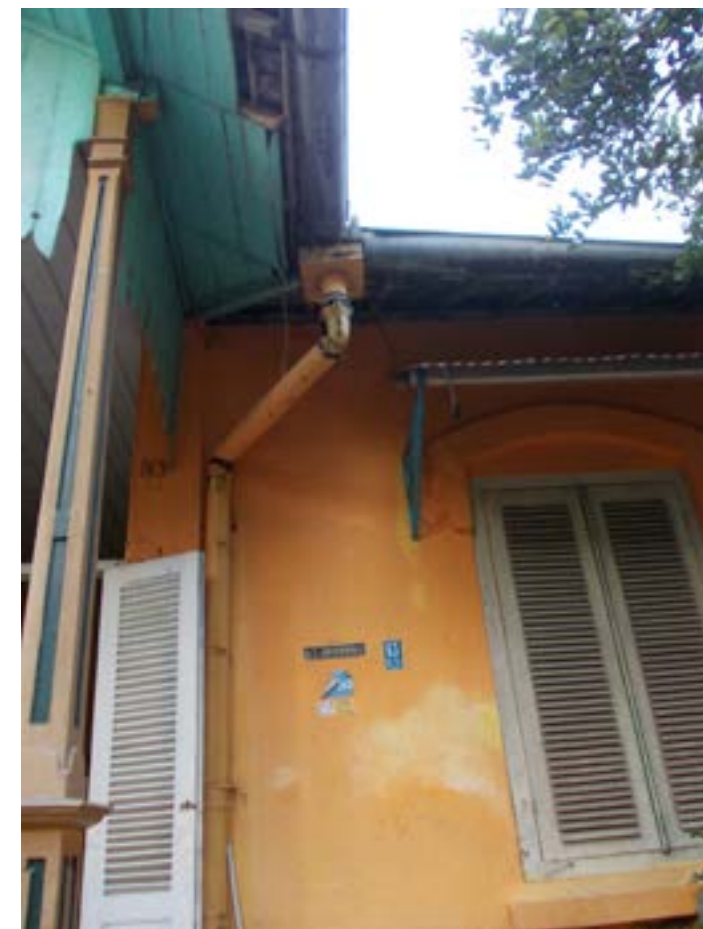
Sistem gutter pada bangunan rumah dinas eks Pabrik Gula Kalasan
