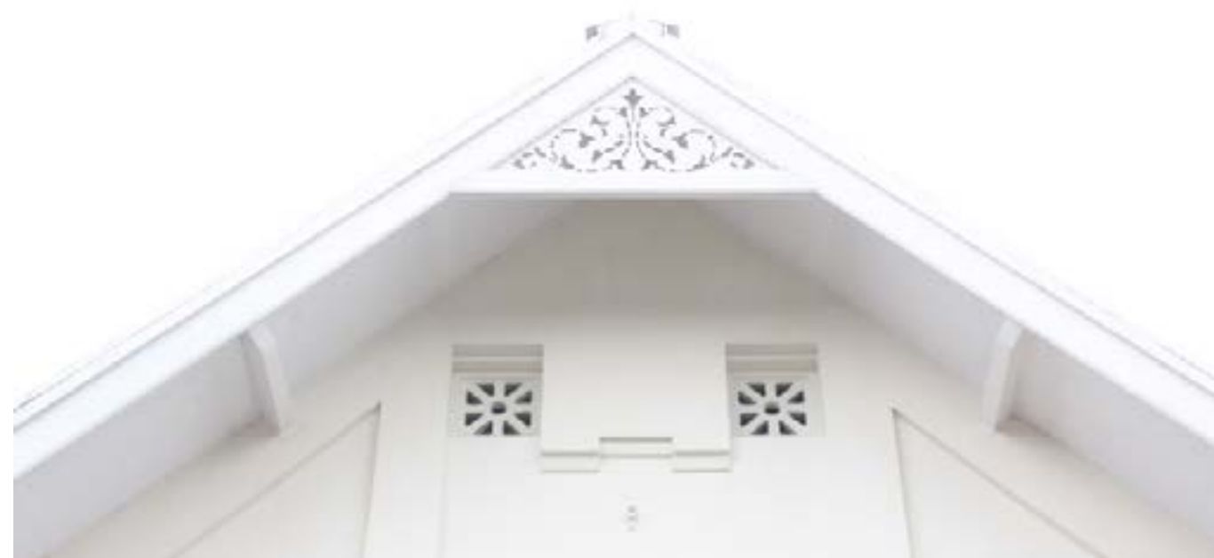
Voorschot berbentuk segitiga dan terletak di bagian fasad bangunan dengan ragam hias berupa gunungan pada bangunan Mess Dirjen Perbendaharaan Kotabaru
