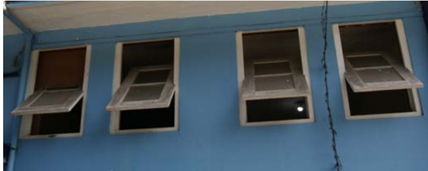
Bentuk jendela projected window pada bangunan Gedung Radio Republik Indonesia
