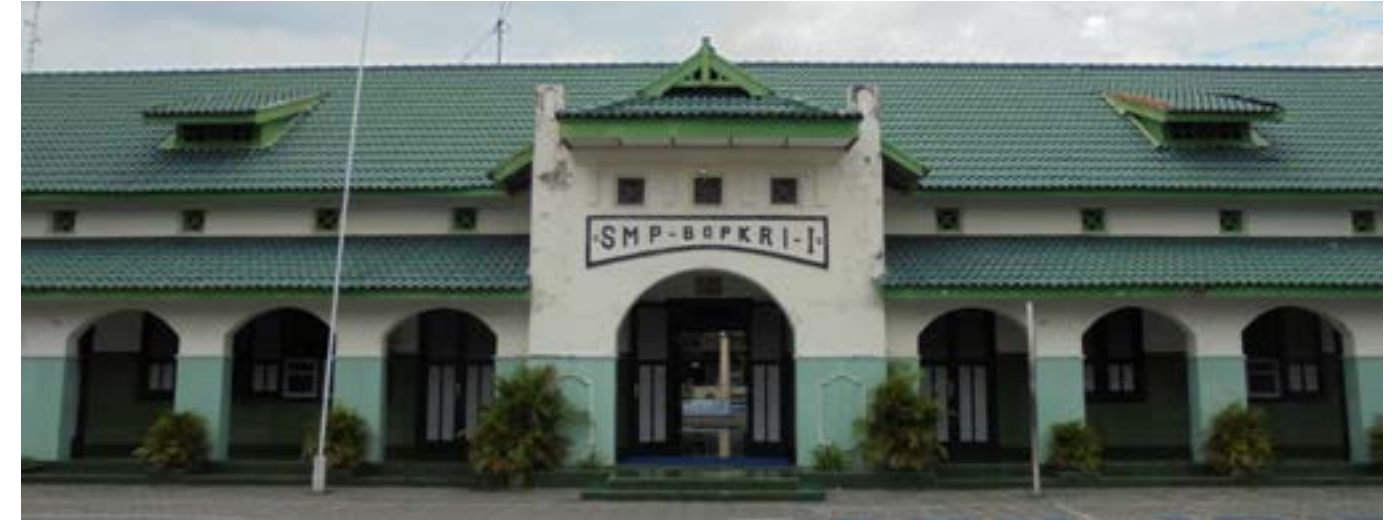
Hipped dormer pada bangunan SMP BOPKRI 1 Yogyakarta
