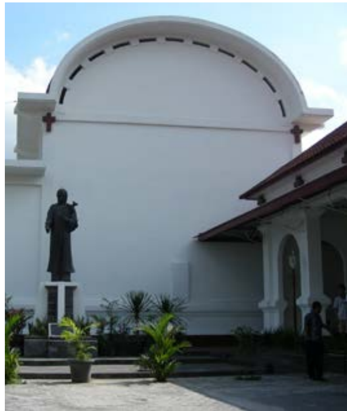
Sistem konstruksi Atap berbentuk barrel vault pada Gereja Santo Yusup Bintaran
