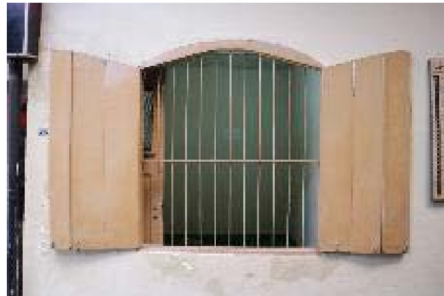
Rumah tinggal di Jl. Abubakar Ali No. 26 Kotabaru
