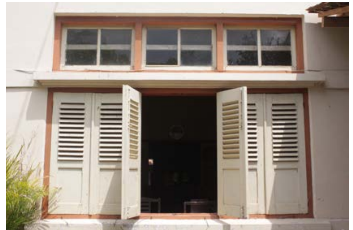
Drip cap Rumah Jl. I Dewa Nyoman Oka No. 11 Kotabaru
