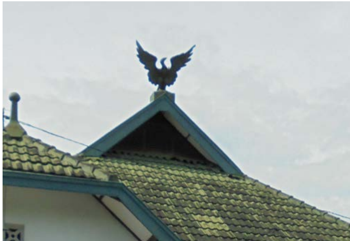
Kemuncak ornamen burung angsa pada atap bangunan MAN II Yogyakarta (Sumber: Dinas Kebudayaan DIY, 2016)
