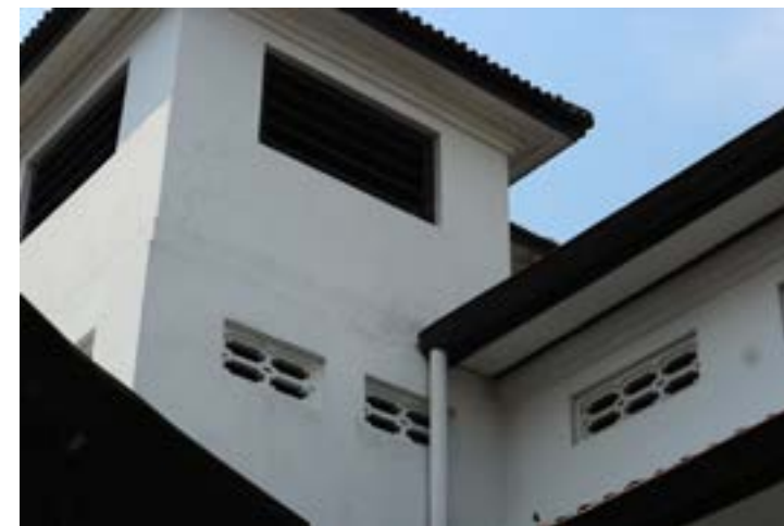
Lubang ventilasi pada bangunan Gereja HKBP di Kotabaru
