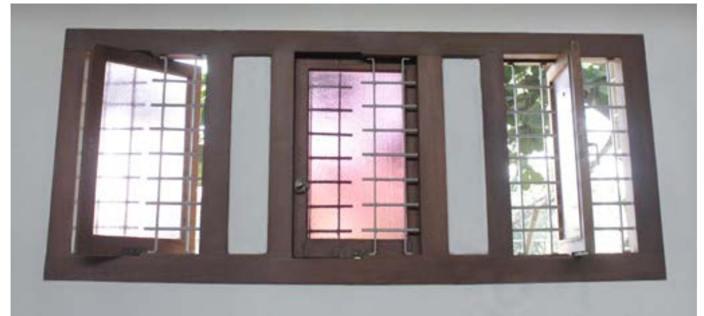
Jendela dengan daun jendela putar pada bangunan Gereja Santo Antonius
