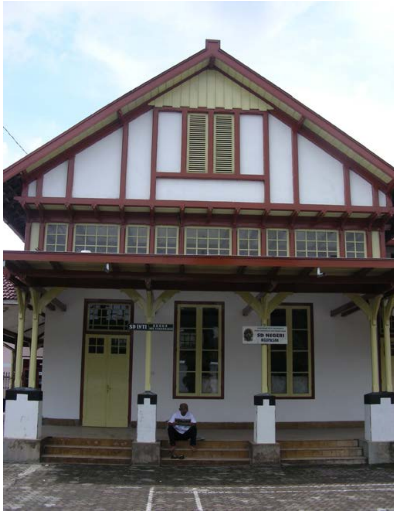
Gable Window pada bangunan SD Ngupasan
