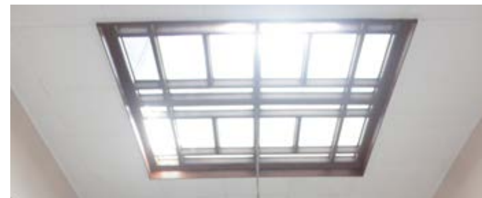
Skylight pada plafon yang terbuat dari frame kayu dan kaca sebagai pencahayaan alami di Ruang Petronella RS Bethesda
