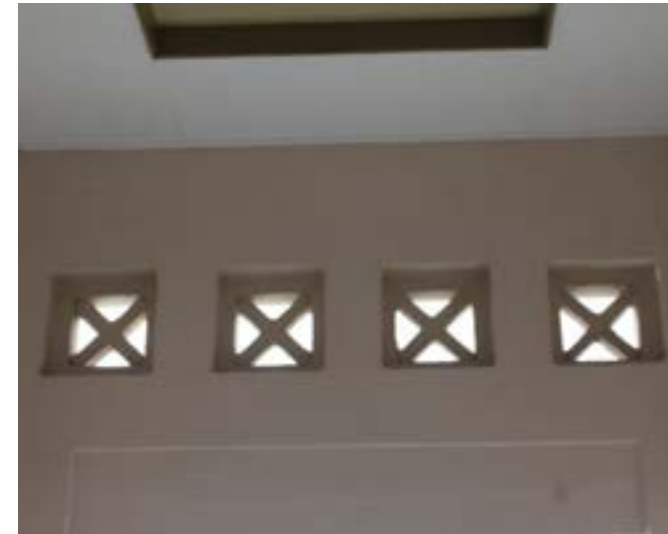
Roster dengan bentuk persegi dan bentuk celah menyerupai huruf 'x' di Ruang F (Ruang Rawat Inap) di RS Bethesda
