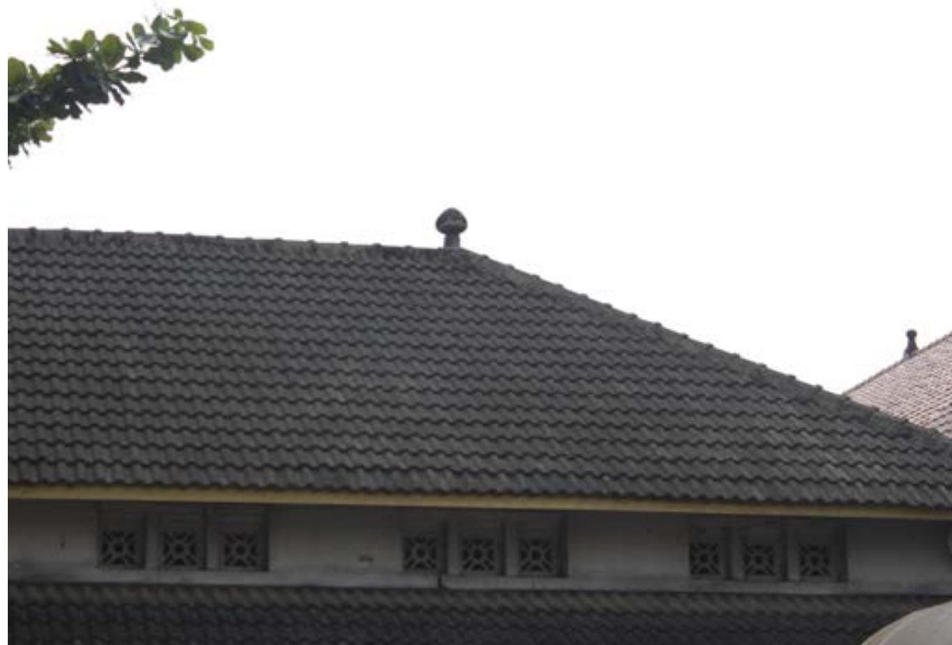
Atap limasan bangunan SD Ungaran, Kota Baru
