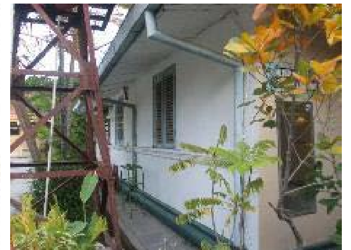
Belt Course pada bangunan SMP 1 Berbah
