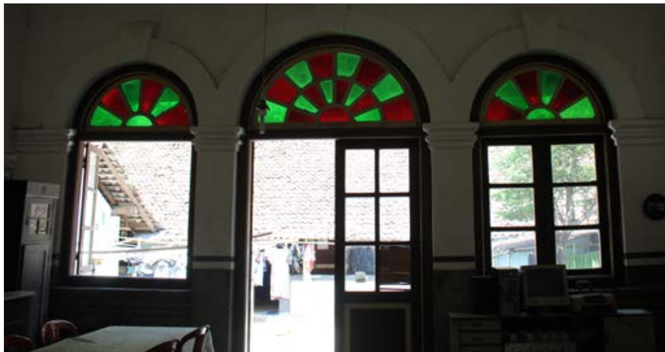
Fanlight pada bangunan bekas rumah dinas PG Sewugalur
