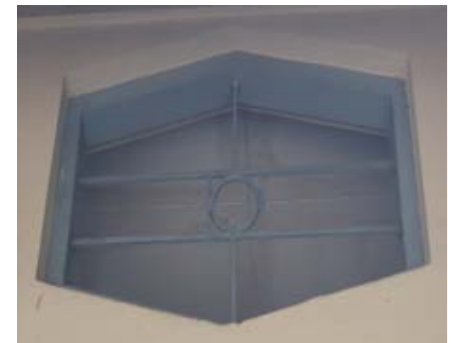
Ventilasi berbentuk segi enam horizontal di Bangunan SMAN 3 Yogyakarta
