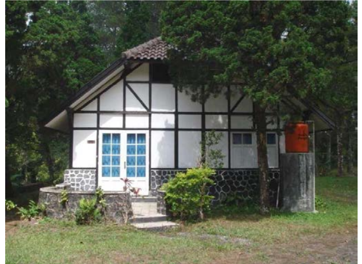
Fasad Vila G.B.P.H. Hadikusumo di Kaliurang yang menggunakan timber frame
