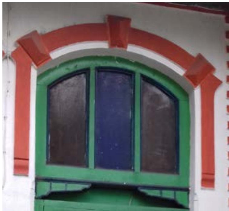
Bentuk pelengkung ambang batas atas (segmental arch) pada bovenlicht di Bangunan Kodamkar
