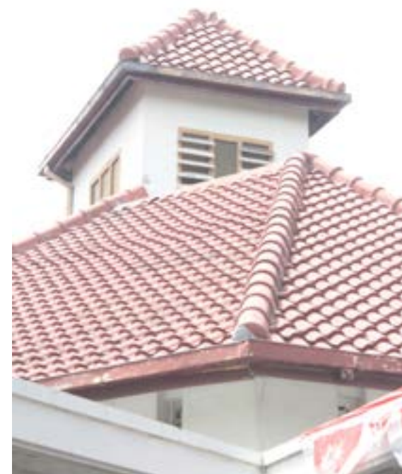
Bangunan Pastoran Kotabaru
