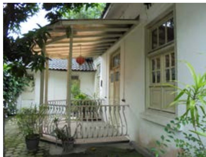
Balustrade pada Bangunan Rumah Fajar Handika Purbandhini di Kawasan Jetis
