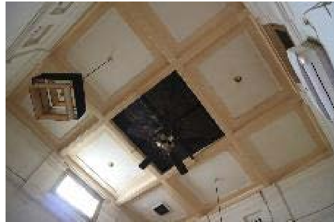
Plafond asli menggunakan material kayu dengan pola grid.
