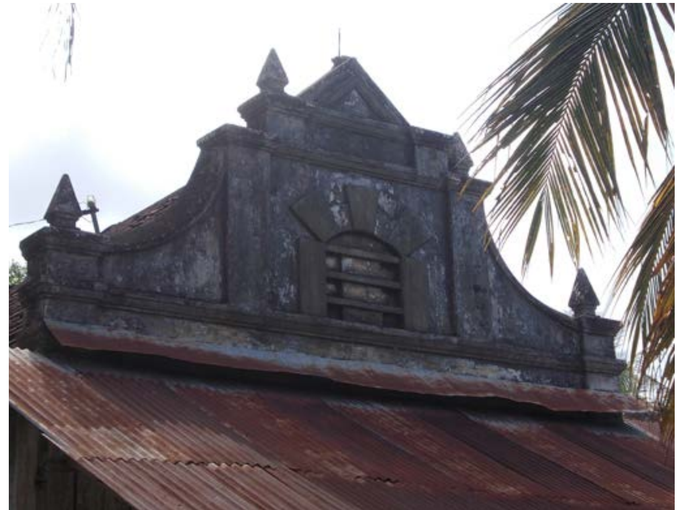
Curvilinear gable pada Eks Rumah Dinas Pabrik Gula Sewugalur milik Ibu Pujarwati
