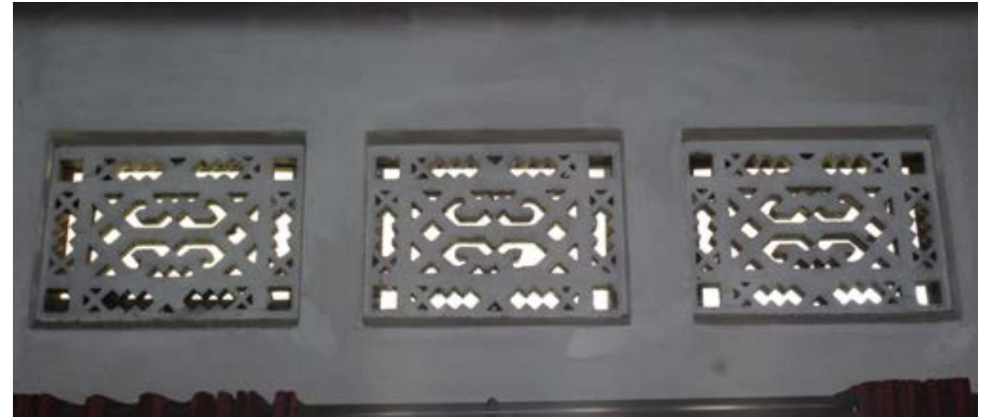
Roster berpola Pada bangunan Rumah tinggal di Jl. Abubakar Ali No. 4A Kotabaru
