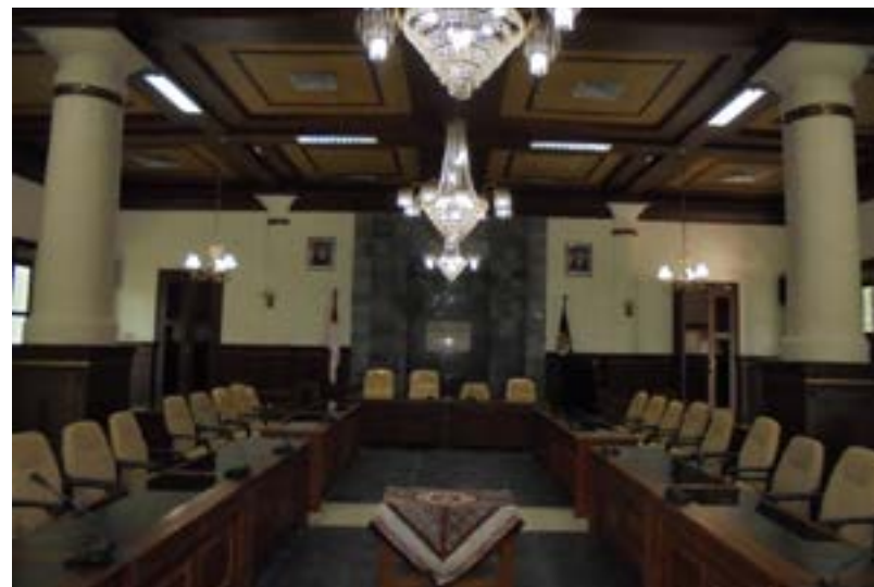
Bentuk Kolom tuscan order pada Ruang pertemuan gedung DPRD Sumber foto: Dinas Kebudayaan DIY
