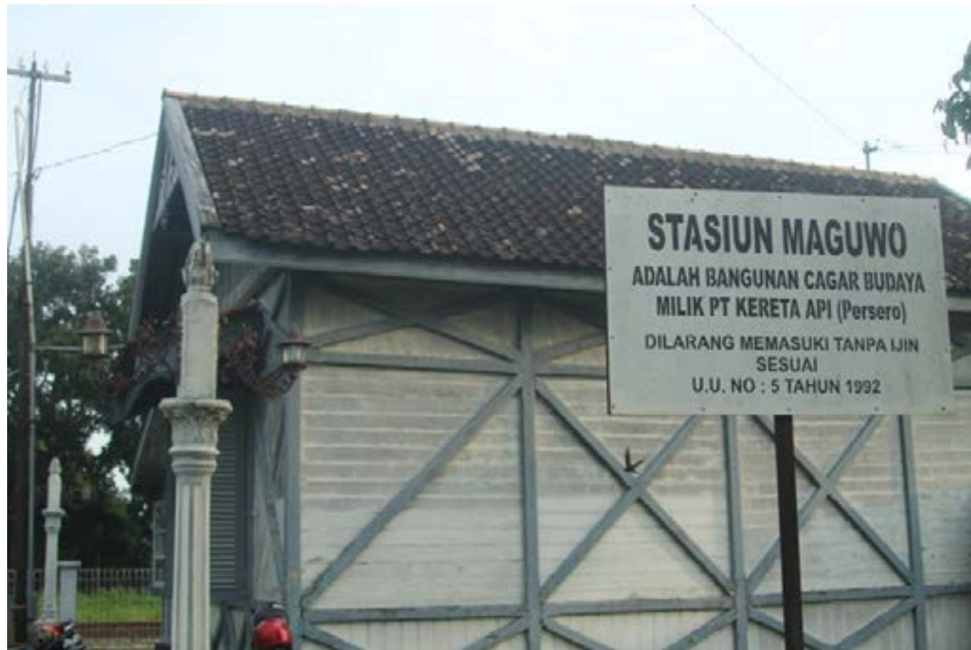
Bagian belakang Stasiun Maguwo Lama Sumber: Dinas Kebudayaan DIY
