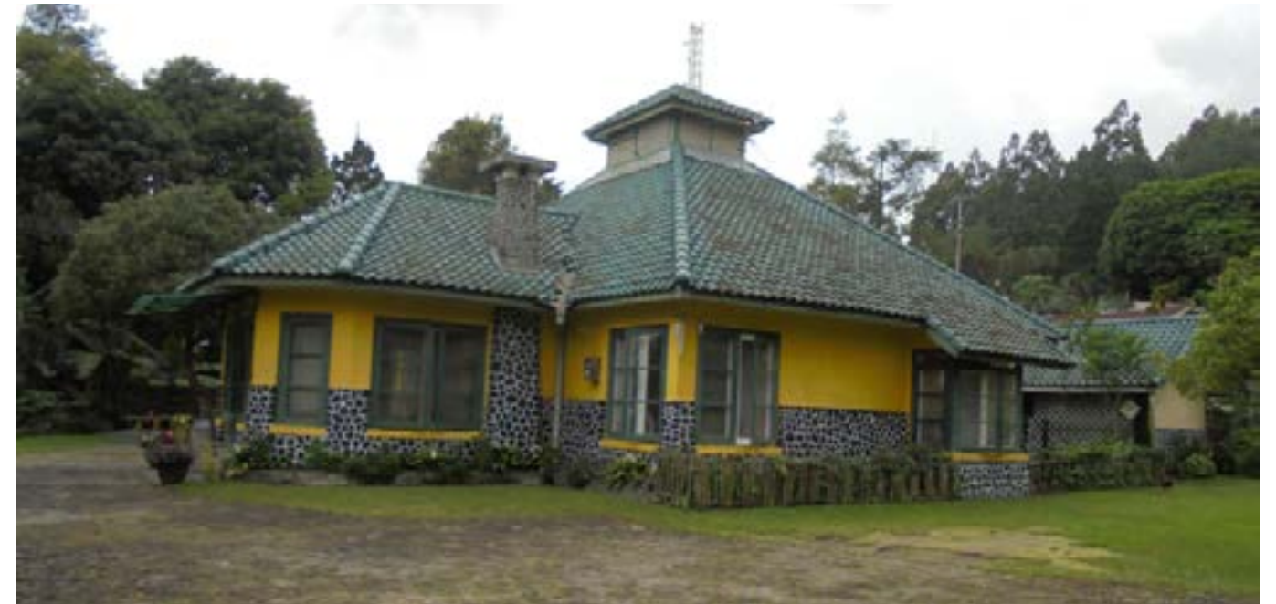
Bangunan Vila Sanggar 3B Sumber: Dinas Kebudayaan DIY
