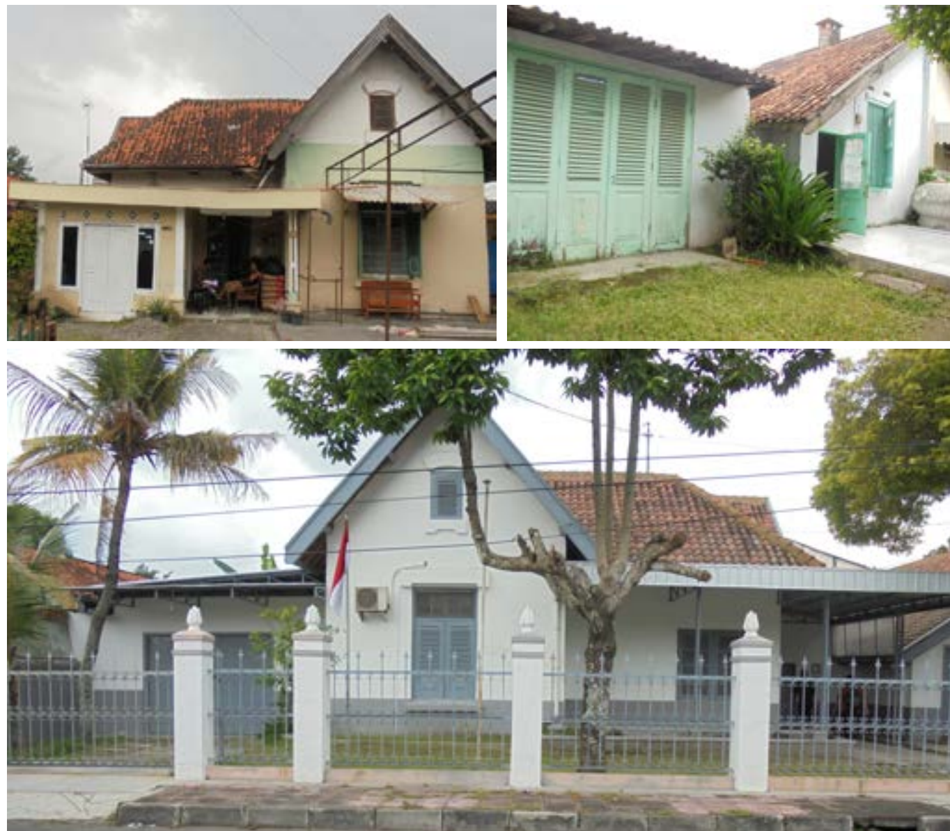
Bangunan Rumah Dinas PT KAI di Bumijo
