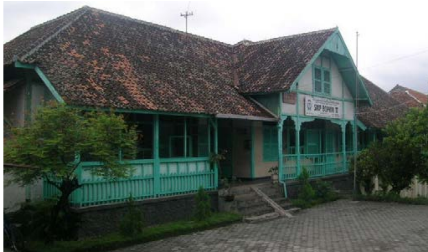
Bangunan lama SMP Bopkri II Yogyakarta dari sisi timur laut Sumber : Dinas Kebudayaan DIY
