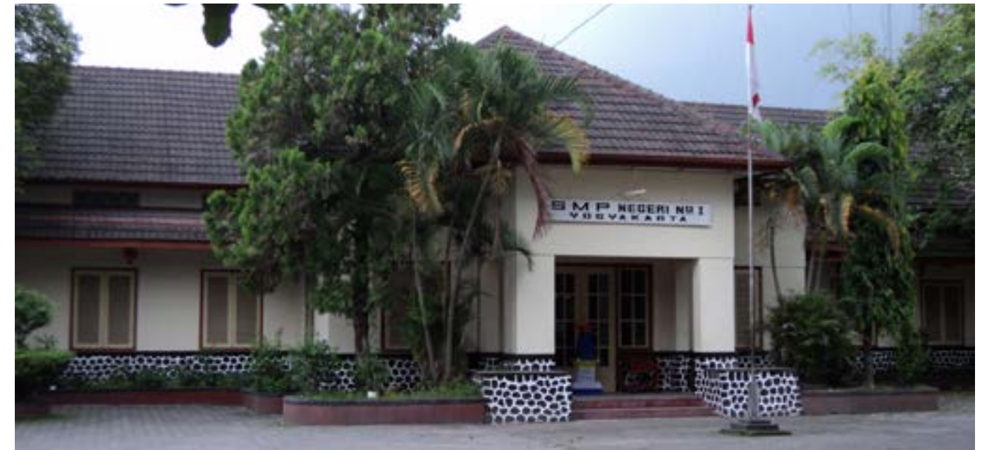
Bangunan SMP N 1 Yogyakarta Sumber: Dinas Kebudayaan DIY
