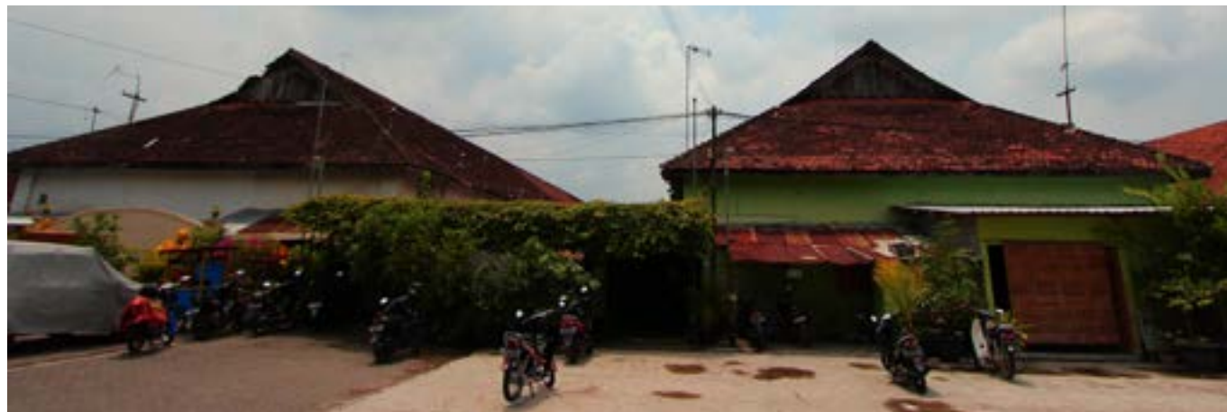
Bangunan Asrama Kompi Kotabaru Sumber: Dinas Kebudayaan DIY
