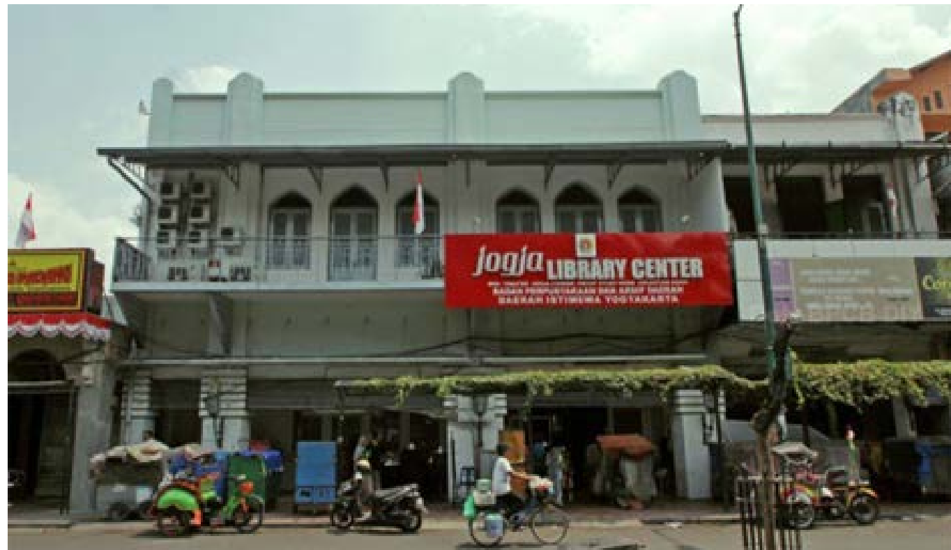
Gedung Perpustakaan DIY di Malioboro. Bagian kanan (utara) telah ditampakkan Sumber: BPCB DIY
