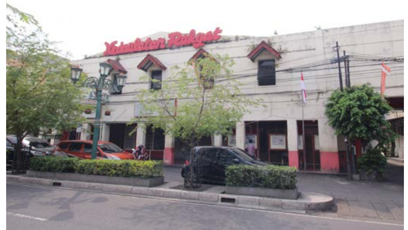
Bangunan Kantor Harian Kedaulatan Rakyat
