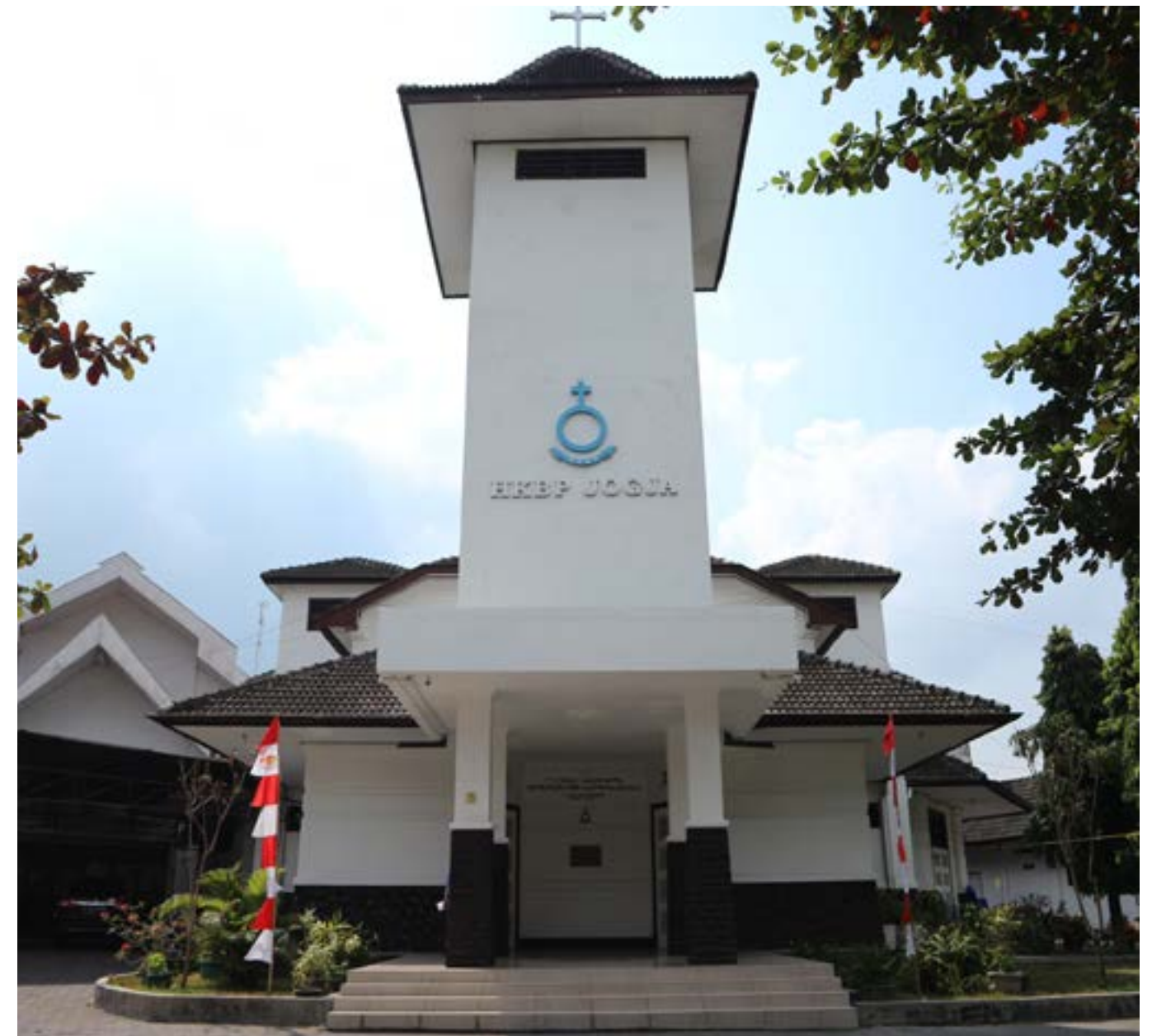
Bangunan Gereja HKBP Kotabaru Sumber: Dinas Kebudayaan DIY
