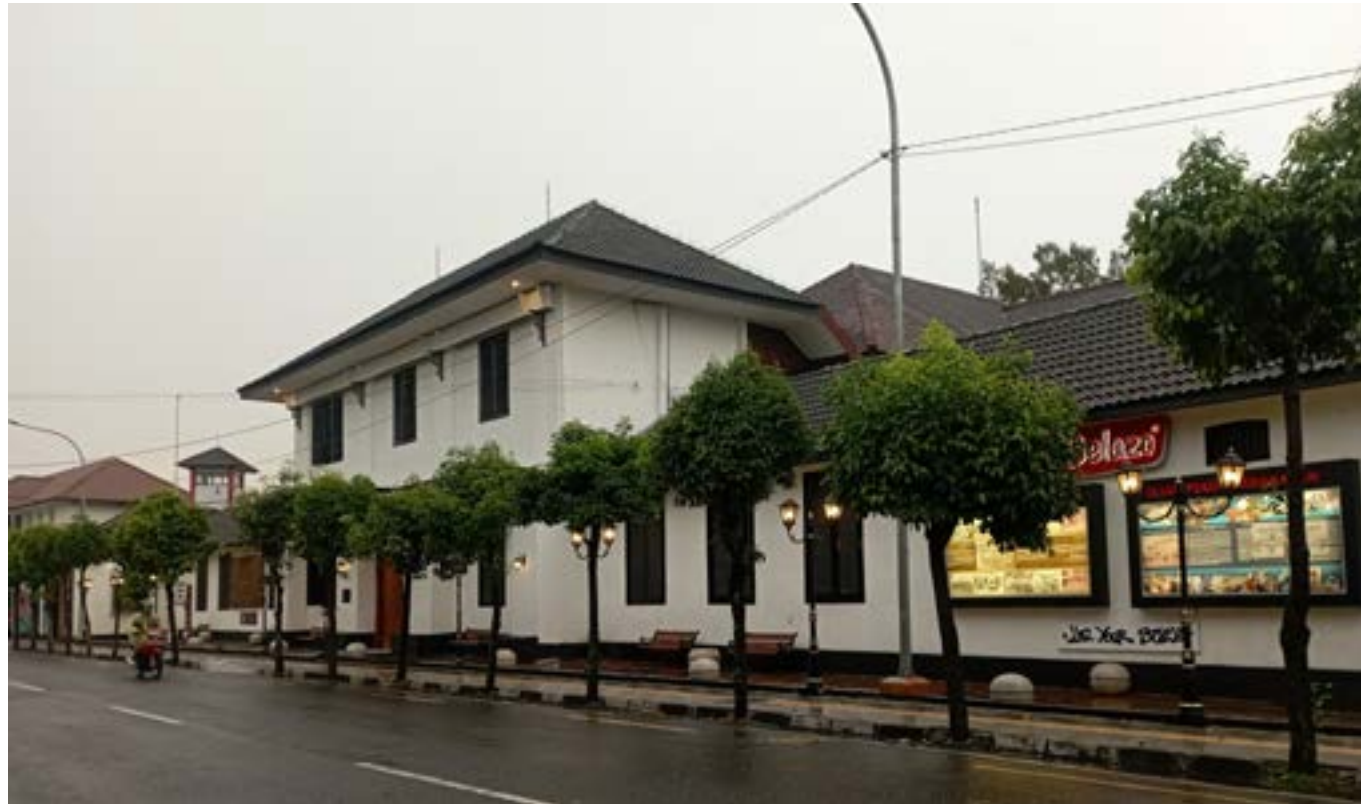
Bangunan Lembaga Pemasyarakatan Wirogunan Sumber : Dinas Kebudayaan DIY
