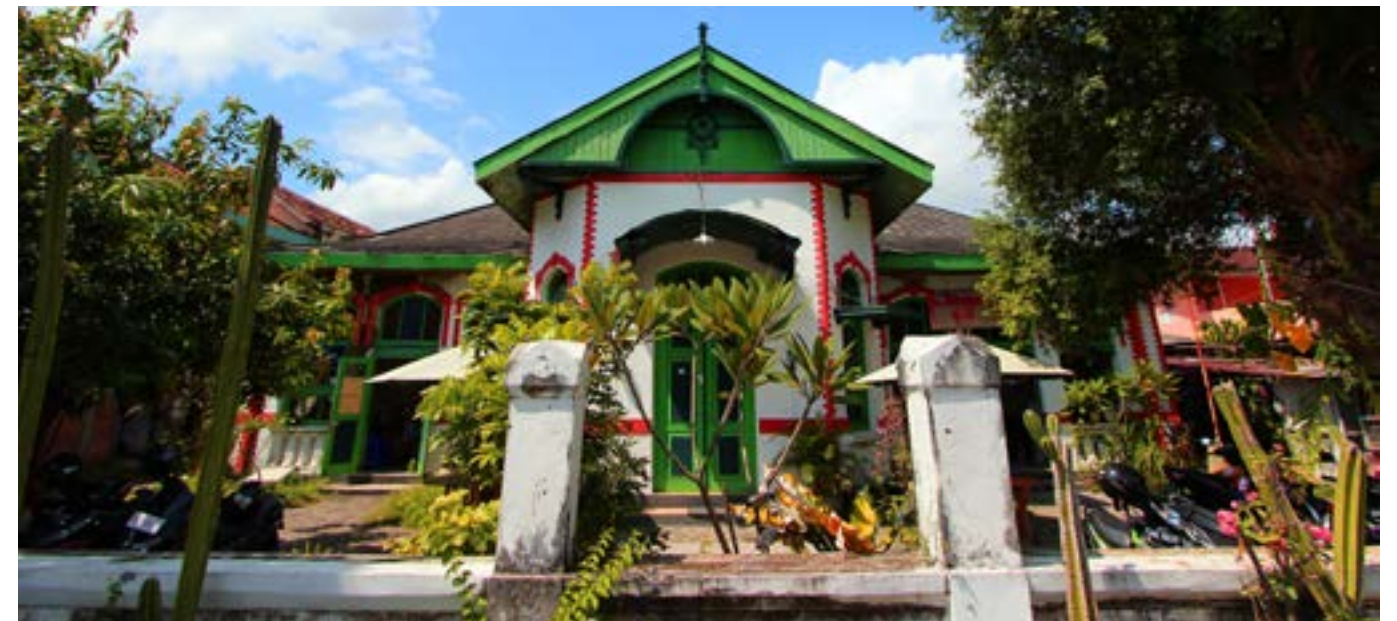
Bangunan Kodamkar di Jl. Bintaran Tengah Sumber: Dinas Kebudayaan DIY
