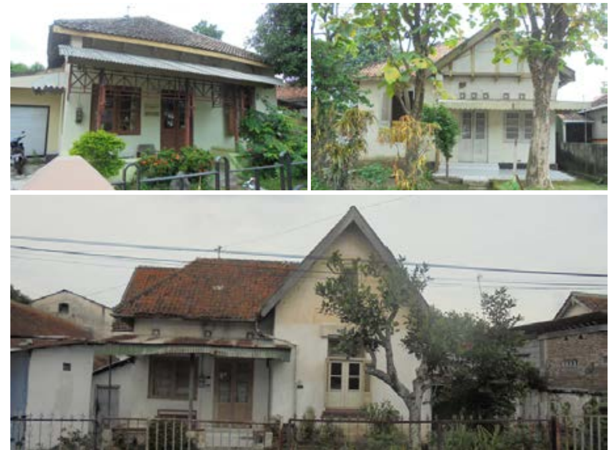
Bangunan Rumah Dinas PT KAI di Bumijo
