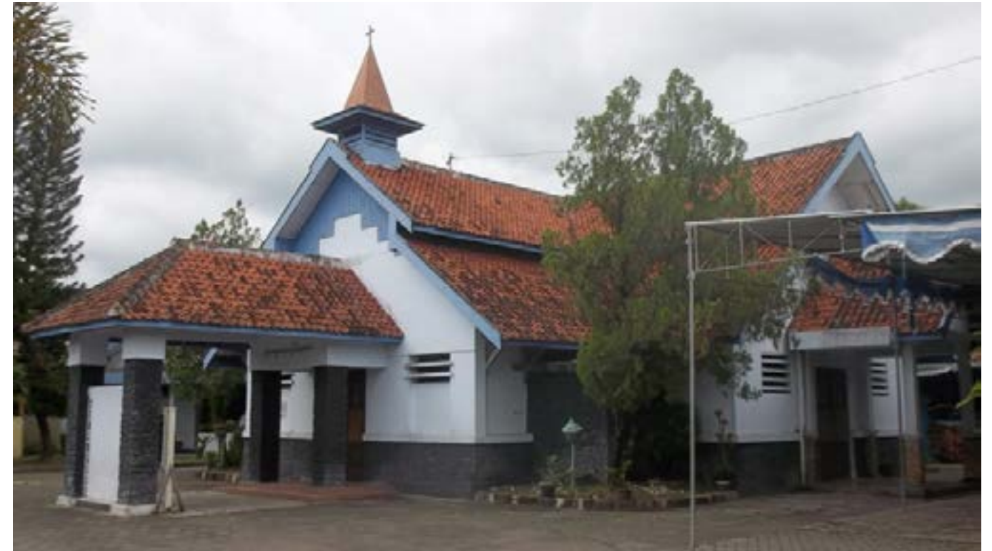
Bangunan GKJ Wates
