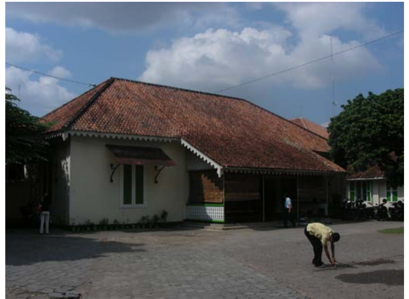
Bangunan SD Tumbuh Sumber: Dinas Kebudayaan DIY
