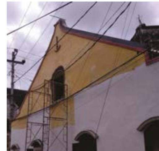
^ Kondisi sisi utara dari Rumah Jl. Ketandan Kidul No. 17, Yogyakarta pada saat dilakukan kegiatan rehabilitasi pada tahun 2020.
