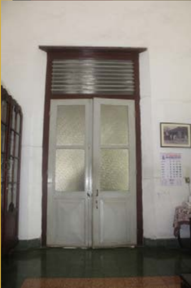
^ (Gambar 1) Pemotongan Daun Pintu Bagian bawah karena perubahan peil lantai akibat dari pergantian tegel. Sumber : Dokumentasi Penulis
