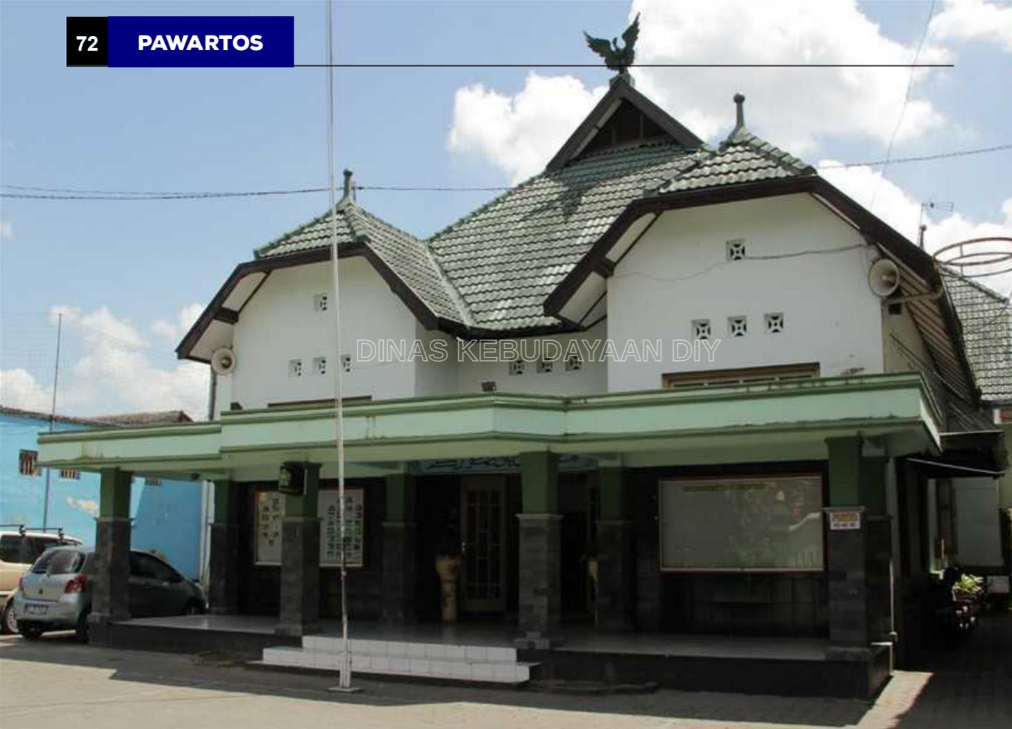
Tampak depan dari MAN 2 sebelum direhabilitasi. Terdapat tambahan ruang teras di depan bangunan dengan penutup atap dari beton. Pada bagian atap, genteng yang digunakan adalah genteng beton
