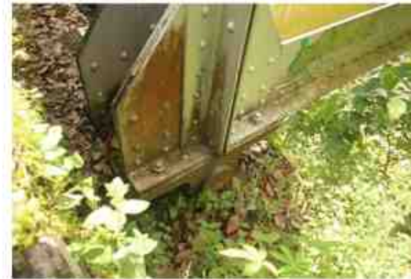
Dari atas ke bawah: Sistem Rol Sisi Timur; Sistem Engsel Sisi Barat Sumber: Naskah Rekomendasi Penetapan Cagar Budaya Struktur Jembatan Pangukan Tahun 2016
