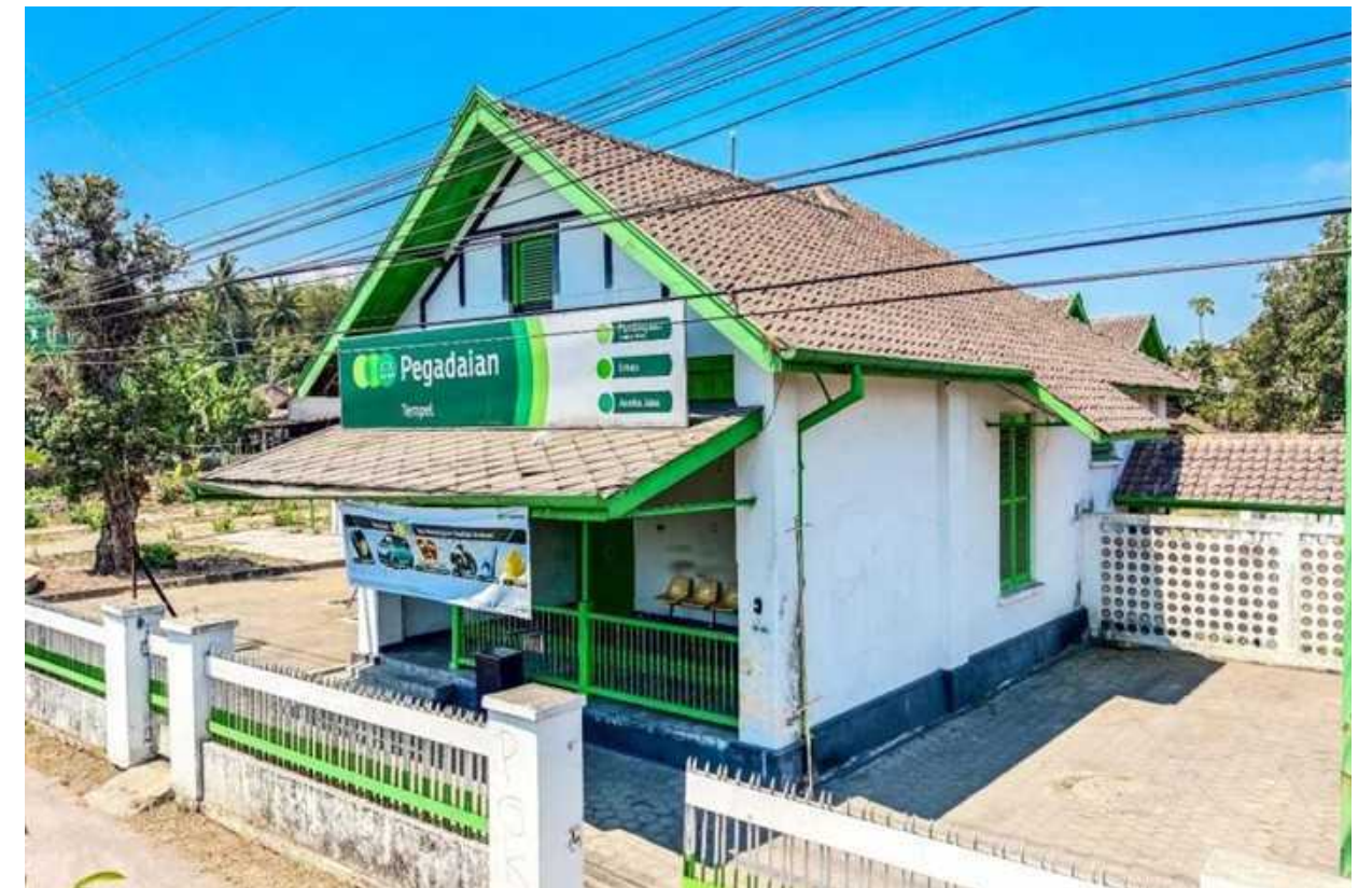
Bagian bangunan rumah beheeder sumber: Dokumentasi Penulis, tahun 2023
