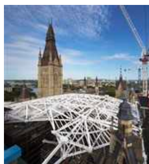
Proses penambahan atap kaca sebagai atap Ruang Sidang sumber: https://www.ojdrovic.com/westblock
