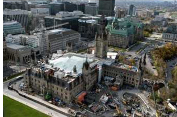
Foto tampak atas yang memperlihatkan atap kaca pada bagian tengah bangunan sumber: https://www.canada.ca/en/public-services-procurement/services/infrastructure-buildings/parliamentary-precinct/projects-in-parliamentary-precinct/west-block-project.html
