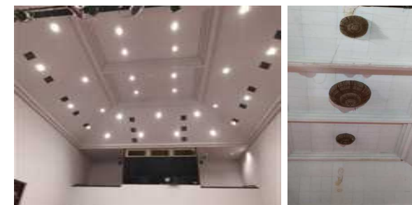
Lampu gedung pertunjukan sebelum dan sesudah pemugaran. sumber : Dokumentasi Penulis
