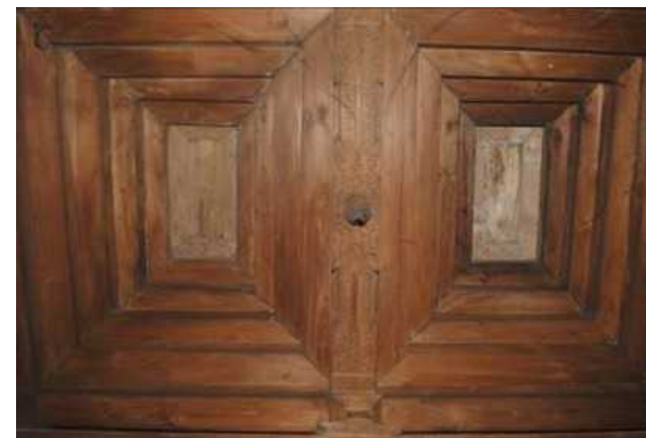
Detail dhadha peksi, balandar singup, dan plafond sumber : Dokumentasi Penulis
