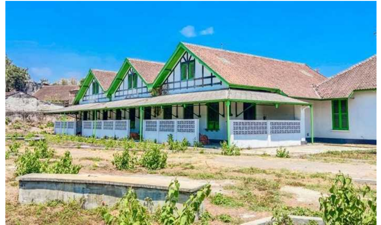
Bagian Bangunan Kantor Pegadaian sumber: Dokumentasi Penulis, tahun 2023
