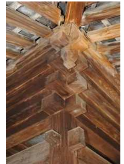
Susunan balok tumpangsari dengan gimbal, dan penguncii emprit gantil sumber : Dokumentasi Penulis
