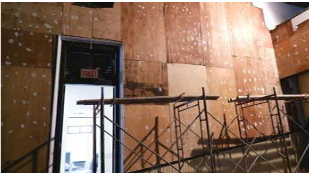
Kondisi dinding dan panel pada ruang pertunjukan pada saat dibongkar. sumber : Dokumentasi Penulis
