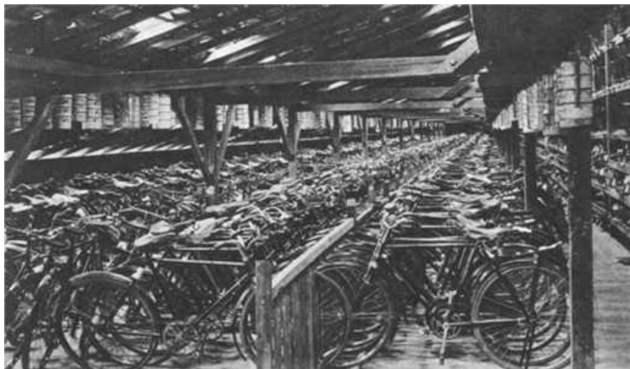
Suasana ruang penyimpanan sepeda yang digadaikan sumber : Gedenkschrift 25 Jarig Gouvernements Pandhuisdienst, tahun 1926
