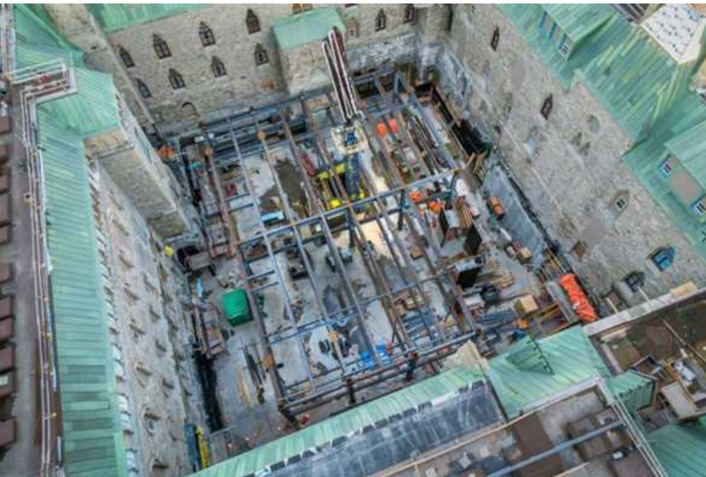
Proses penambahan atap kaca sebagai atap Ruang Sidang sumber: https://www.ojdrovic.com/westblock
