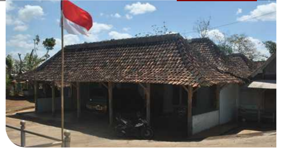
Rumah Merto Sayuk di Paliyan - Tempat Singgah Jenderal Sudirman Sumber: TACB Gunungkidul, 2020 >
