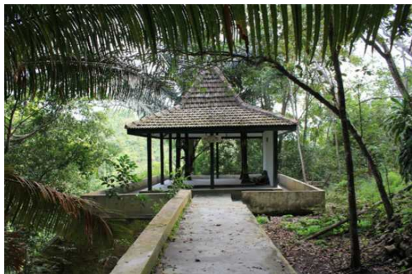
^ Bangunan Paseban Kembang Lampir Sumber: Dokumentasi TACB Gunungkidul, 2017
